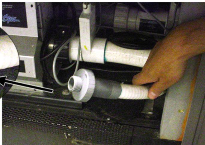
5. Raccordez l'extrémité femelle d'un tuyau d'arrosage au dispositif de vidange.
