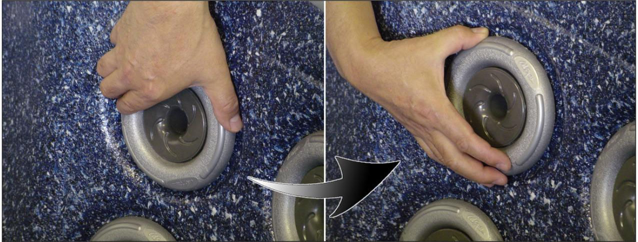
Pour remplacer un jet, insérez-le et poussez-le dans son logement et faites-le tourner dans le sens des aiguilles d'une montre, jusqu'à ce qu'il s'enclenche. Lorsque la face du jet peut tourner librement, il est correctement installé.
